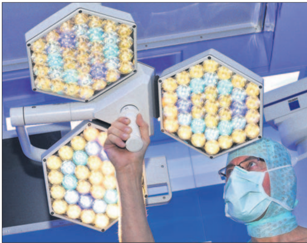
Die OP-Lampe im neuen OP-Saal besteht aus vielen kleinen LED-Leuchten, die kaum Wärme abstrahlen und ein angenehmes Licht erzeugen. —FOTO: KKRN
